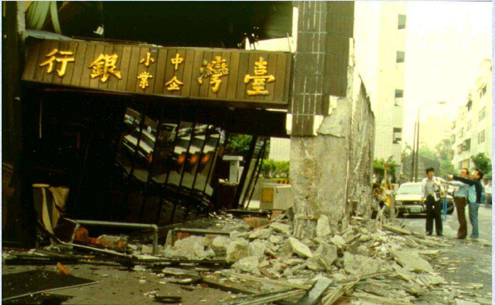
台北市復興南路一段某大廈，一樓剪力牆腳及牆邊構材部份被壓碎，鋼筋暴露且扭曲變形，牆面呈斜向之剪力龜裂，一、二樓間之混凝土樓板破裂並下陷。
