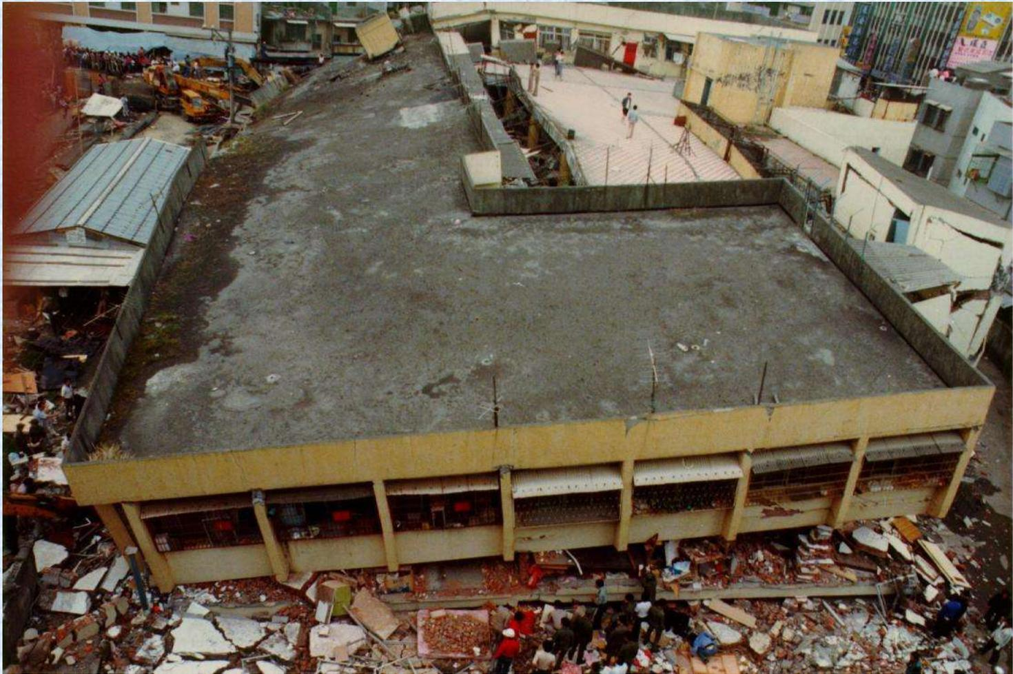
台北縣中和市員山路之華陽市場，原為三層多柱少牆鋼筋混凝土的市場建築物，由於2、3層改為住家後砌築了許多磚造外牆與隔間牆，使得建築物成為上剛下軟的結構，加上過大的超載，在耐震上十分不利。在此次地震襲擊下，幾乎大部份一、二樓的支柱折斷，造成12人死亡，數十人受傷的慘劇。
