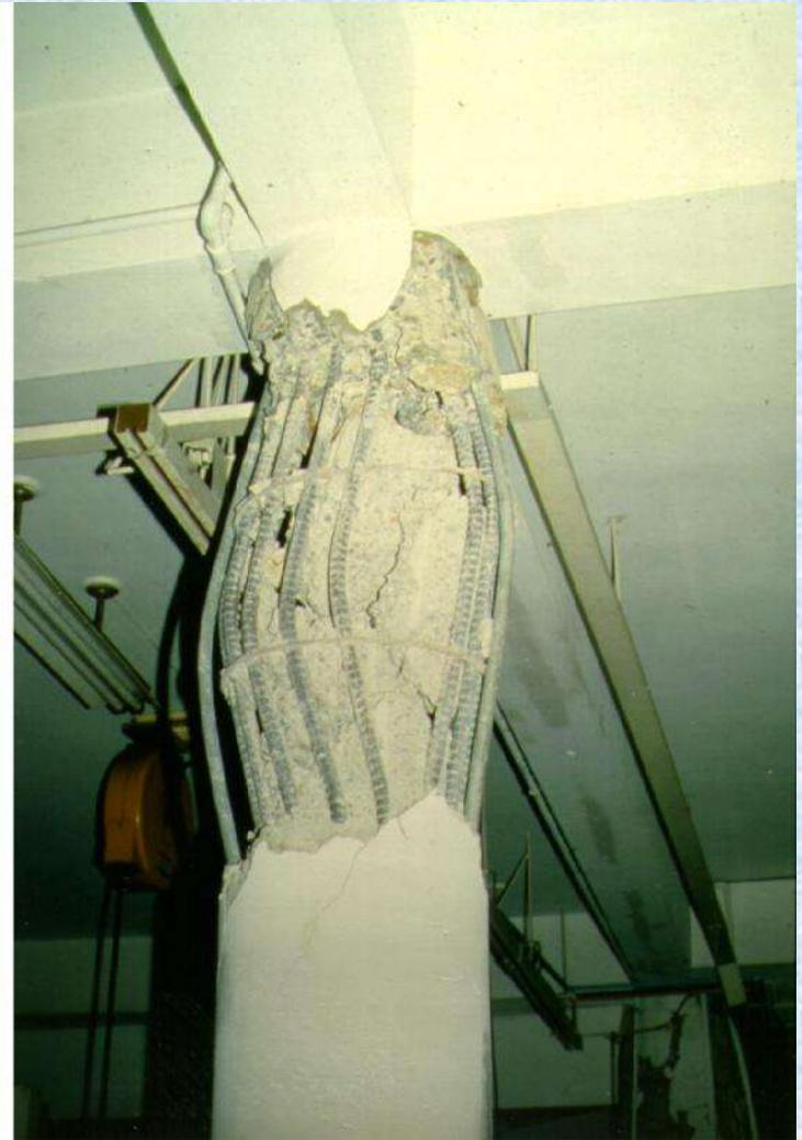
台北市基隆路某汽車公司，門前與建築物中之鋼筋混凝土柱暴裂，鋼筋扭曲變形。
